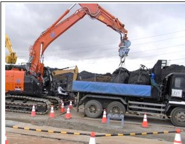
除去土壌等の積込作業
