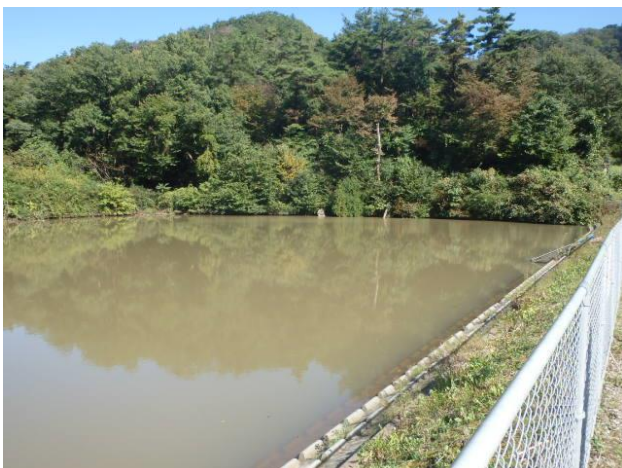
川俣町沼ノ平ため池 被災なし
