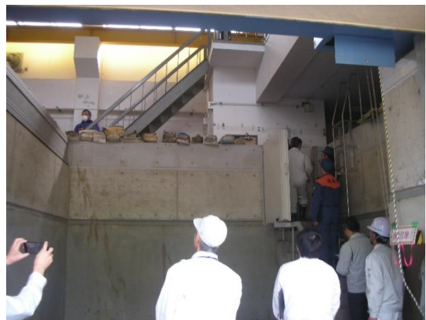
白沢揚水機場内の視察の様子
