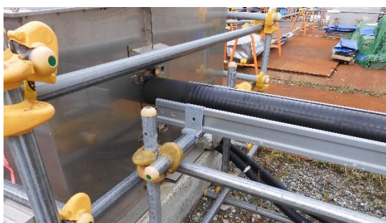
(写真4-2) No. 213ピットの配管接続状況
