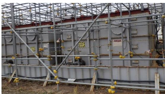
(写真 2 - 2) 受入タンク B 外観 (北西側から撮影)
