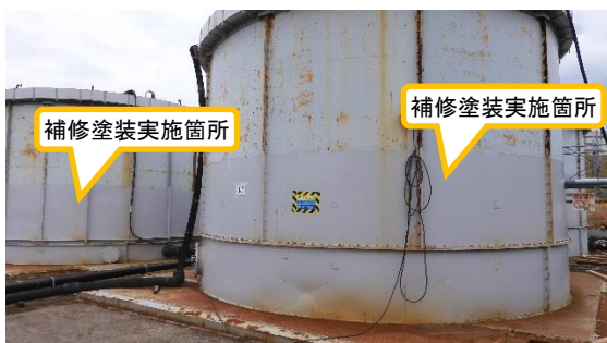
(写真 2 - 3) 受入タンク C 外観 (北東側から撮影)
