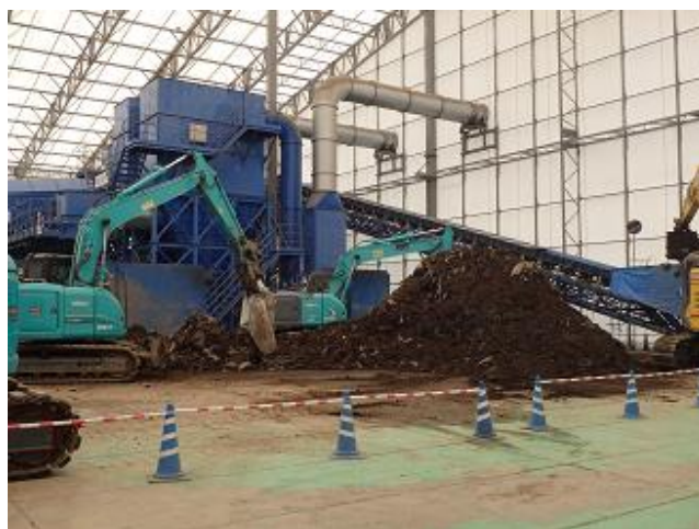
受入・分別施設の稼働状況の確認
