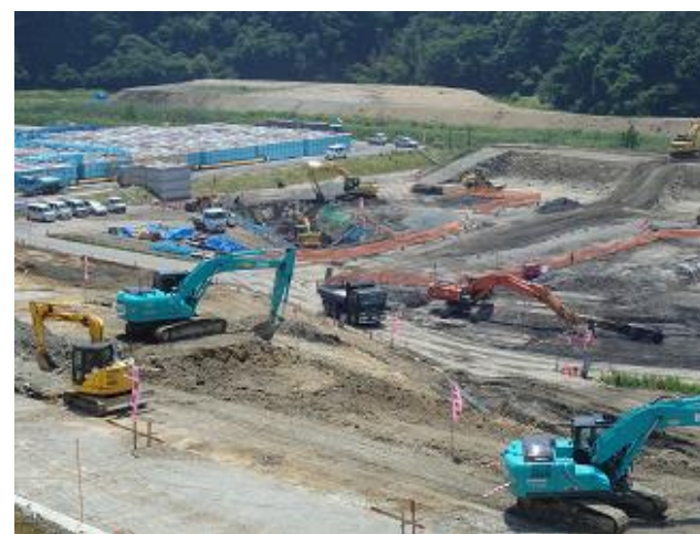
土壌貯蔵施設の稼働状況の確認
