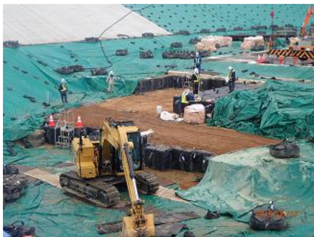
上流側埋立地の埋立状況の確認
