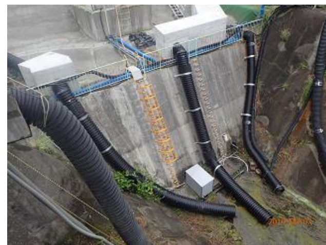
雨水排水管等の状況確認
