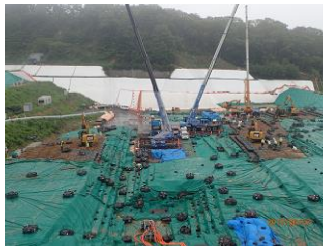
下流側埋立地の埋立状況の確認
