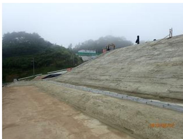
土堰堤の状況確認
