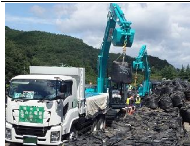
除去土壌等の積込作業
