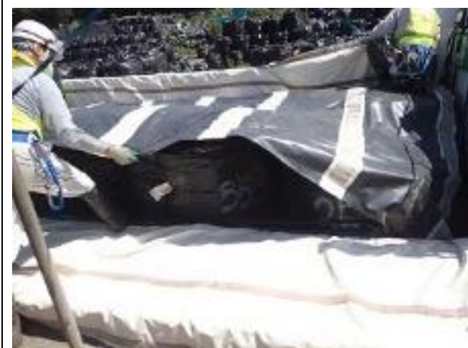
除去土壌等の飛散・流出防止対策
