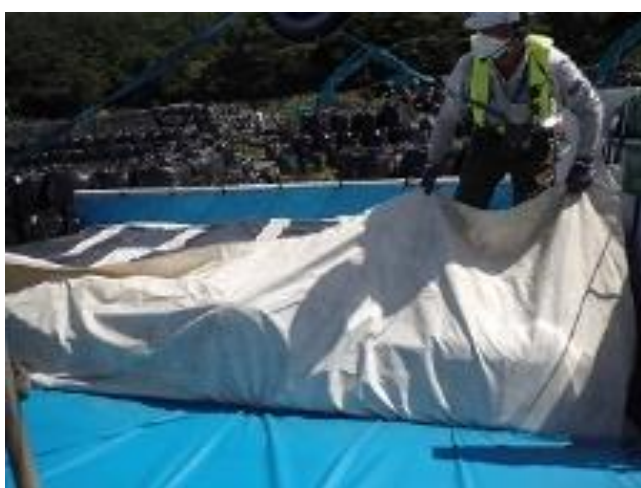
除去土壌等の飛散・流出防止対策
