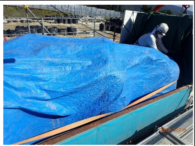
除去土壌等の飛散・流出防止対策
