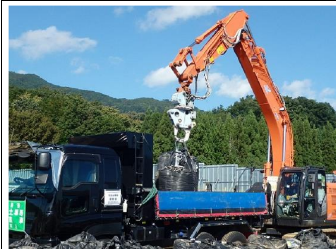
除去土壌等の積込作業
