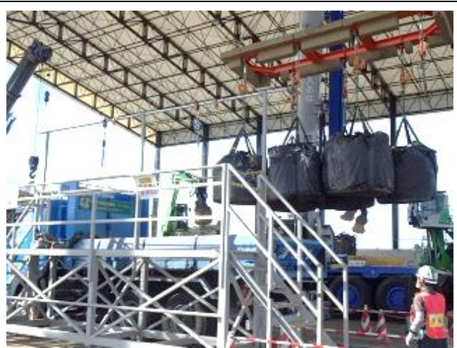
中間貯蔵施設での荷下ろしの状況
