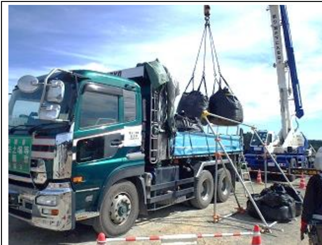
除去土壌等の積込作業確認
