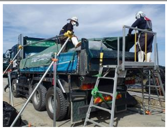
除去土壌等の飛散・流出防止対策
