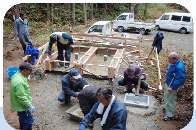
トイレの施工状況
