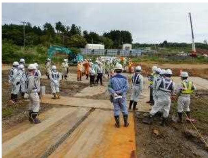
安全パトロールの様子1
