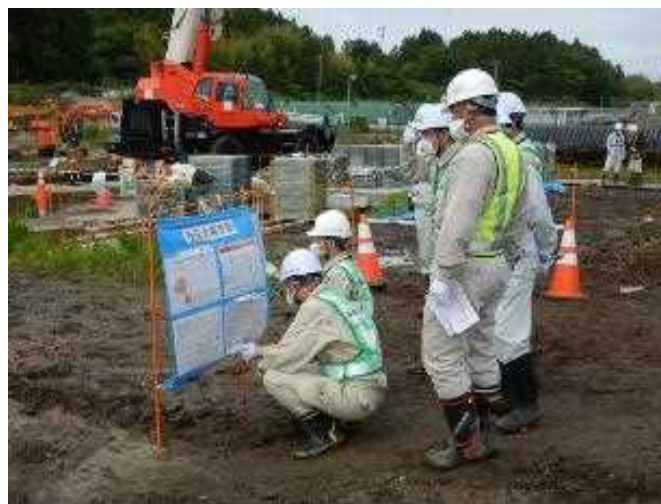
安全パトロールの様子2
