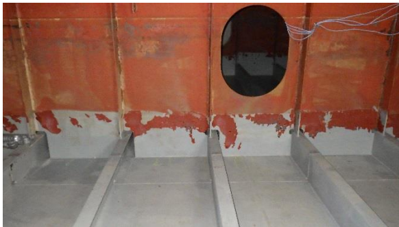
(写真2-1) メガフロート内部で除染が終了した 箇所例
