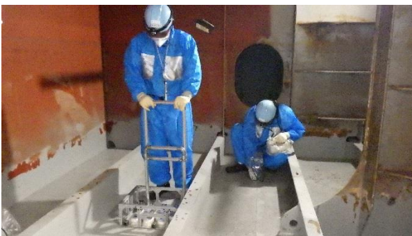
(写真2-2) 除染終了後の表面汚染測定状況
