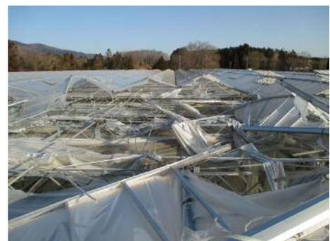
暴風で倒壊した鉄骨ハウス
