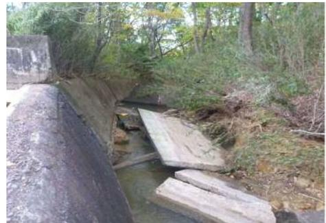
台風で被災したため池洪水吐水路
