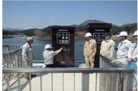
取水ゲートスイッチを操作し取水開始
