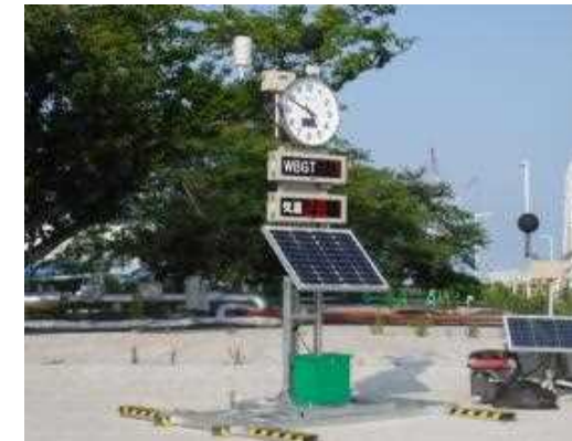
大型WBGT表示器、時計の配備
