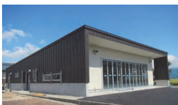
猪苗代水環境センター (猪苗代町)
