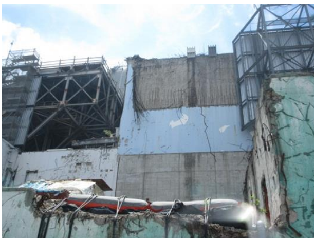
福島第一原子力発電所原子炉建屋
