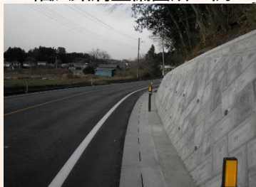
国道294号 (白河市・白坂工区)
