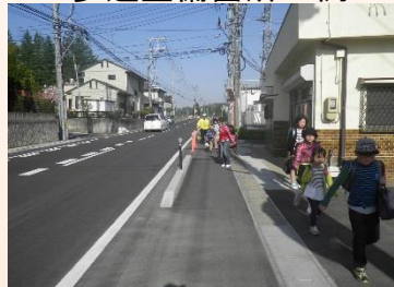
矢吹天栄線 (矢吹町・花咲工区)
