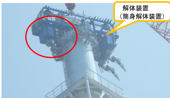
(写真 1 - 1) 垂直梯子の背かご切断工事の状況
