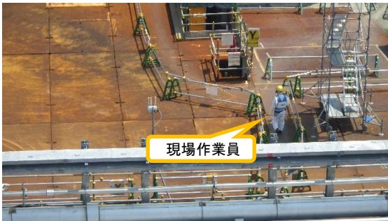
(写真 2 - 2) 排気筒南側において現場作業員が確認している状況 無線で遠隔操作室と連絡を取り合っていた
