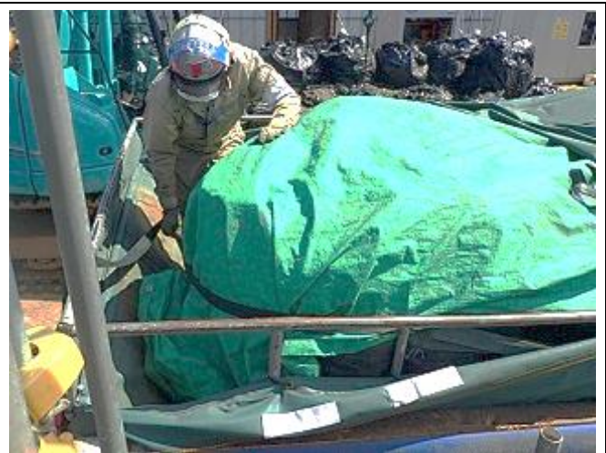
除去土壌等の飛散・流出防止対策
