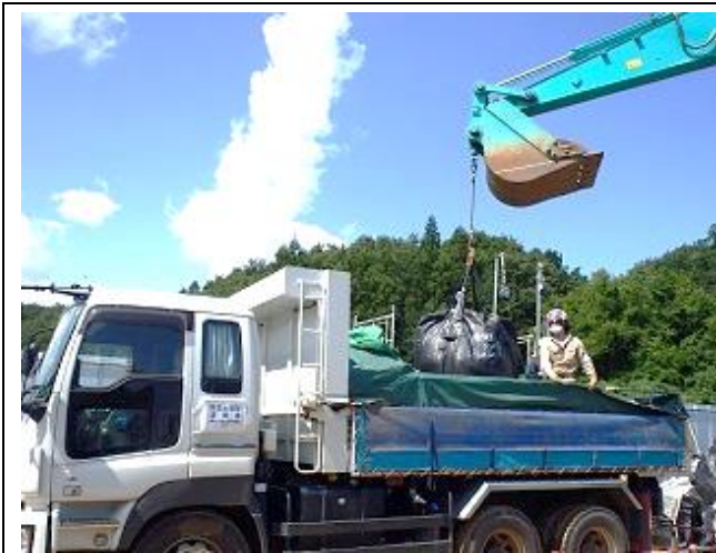
除去土壌等の積込作業
