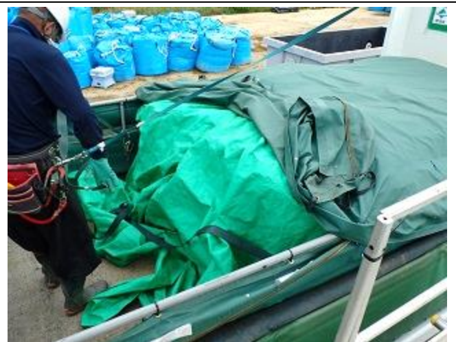
除去土壌等の飛散・流出防止対策
