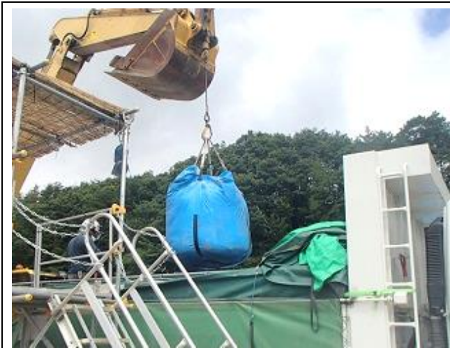
除去土壌等の積込作業
