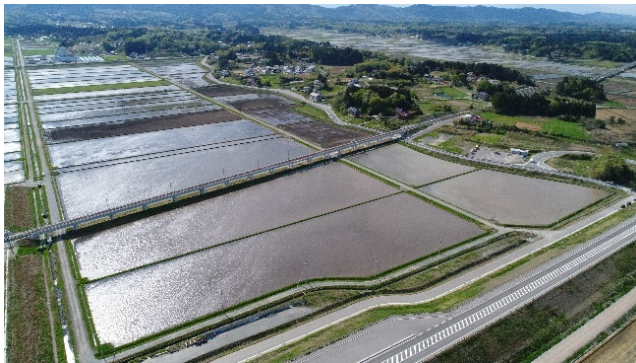
農用地災害復旧関連区画整理事業 作田前地区（新地町）【完了】
