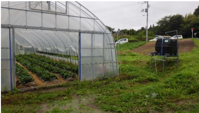
落差かん水装置導入ハウス
