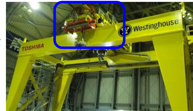
クレーン（○部：補巻）
