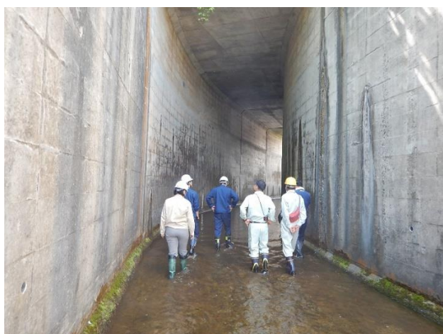
大玉村三ツ森ため池 洪水吐コンクリート状況確認
