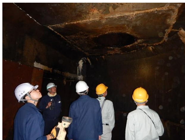
大玉村三ツ森ため池(導水路トンネル内部)コンクリート状況確認
