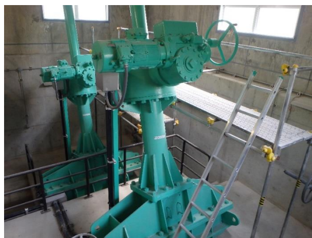
二本松市山ノ入ダム 緊急放流施設の確認
