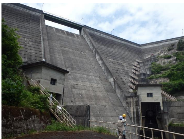
二本松市岳ダム ダム堤体確認
