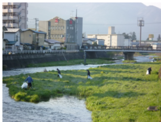
作業状況(湯川城西小付近)
