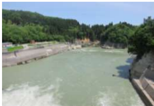
柳津発電所ダム。迫力あります。
