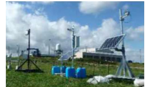
簡易型河川監視カメラ
