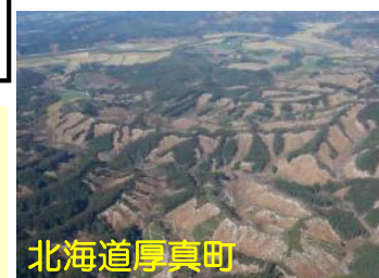
北海道厚真町 大規模な斜面崩壊の様子 (平成30年北海道胆振東部地震) ※出典:国土交通省資料
