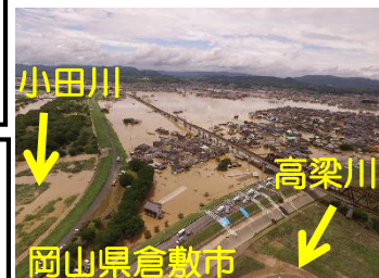
岡山県倉敷市 小田川の浸水被害の様子 (平成30年7月豪雨) ※出典:国土交通省資料
