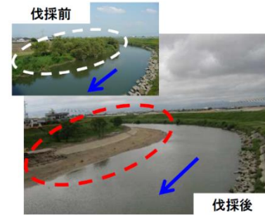
(樹木伐採・河道掘削)
