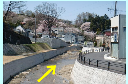
桜川（三春町）河川整備
