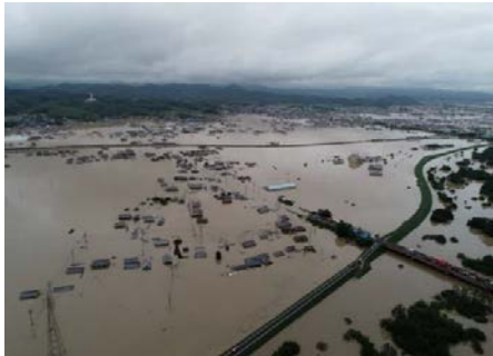
浸水被害の状況 （岡山県倉敷市真備町）
