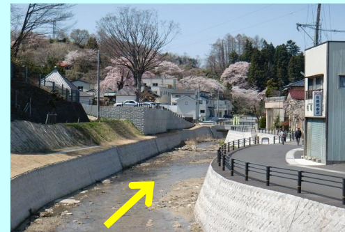
桜川（三春町）河川整備
