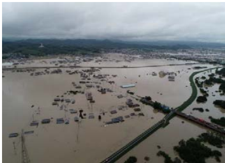
浸水被害の状況 （岡山県倉敷市真備町）
