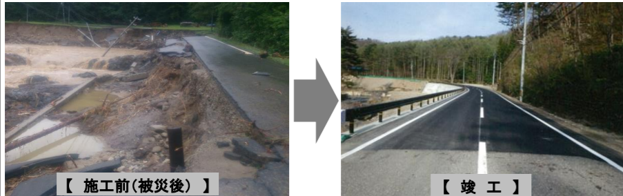
④ 国道352号(戸中地区内)
