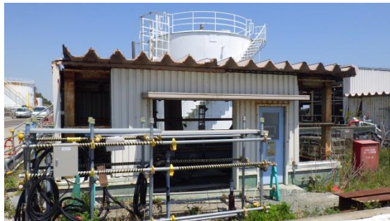
(写真4) 2号機油分離槽建屋
