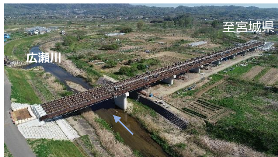
国道349号 梁川バイパス (伊達市梁川町)
