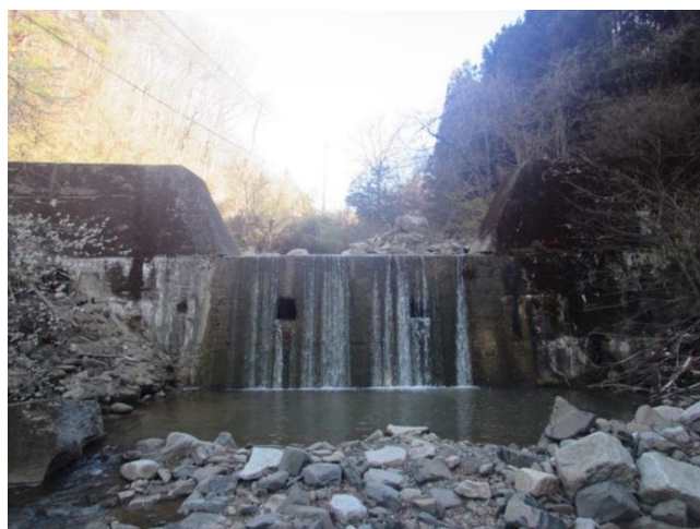
山舟生川砂防えん堤（梁川町）
