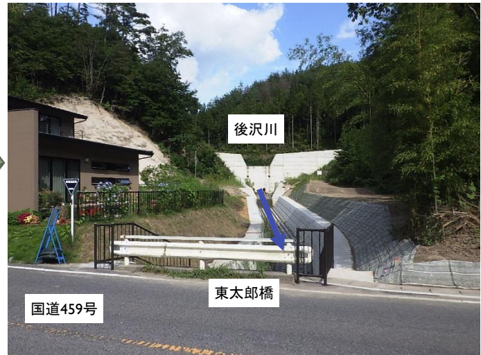
H29砂防えん堤、溪流保全工完了（後沢川） [二本松市西新殿]
