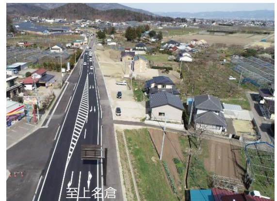
上名倉飯坂伊達線（福島市大笹生）福島大笹生2工区
