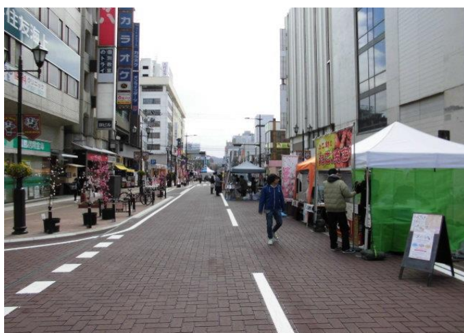
福島停車場線 リニューアル整備 H29完了
