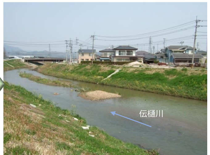
伝樋川（伊達市梁川町） 整備完了箇所
