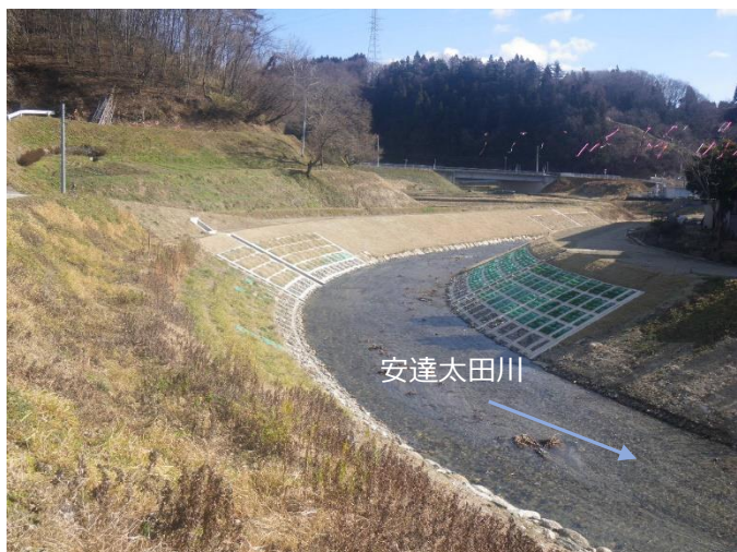
安達太田川（二本松市太田）開削護岸
