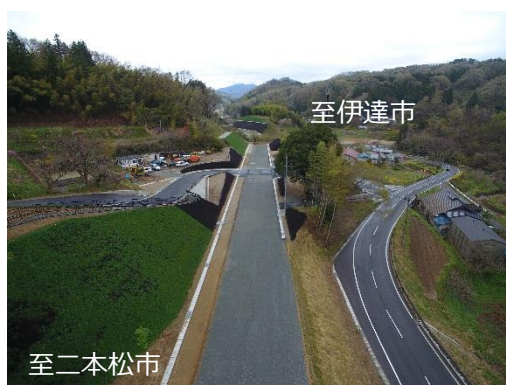
国道349号 大綱木1工区 (川俣町)
