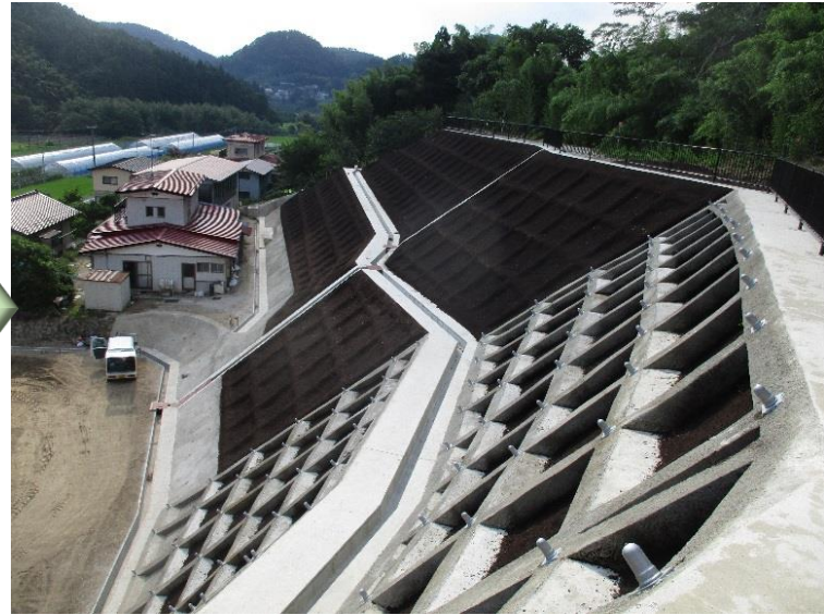
法面処理（中ノ内地区）[伊達市梁川町山舟生]
