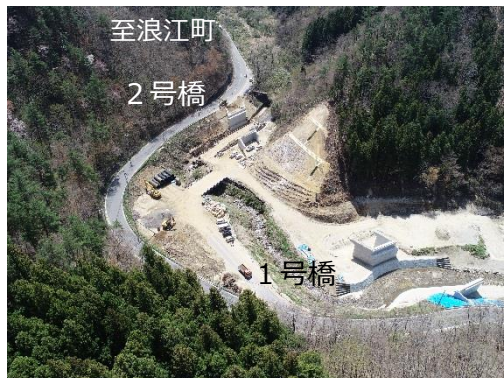
国道114号 山木屋1工区 (川俣町)
