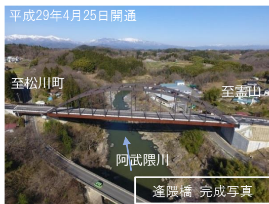
霊山松川線 逢隈橋 (福島市飯野町・松川町)
