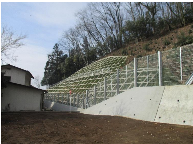
H30法面工完了（羽根山地区） [福島市大笹生]
