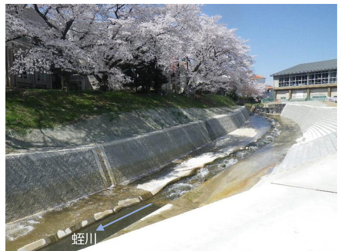
蛭川（福島市瀬上町）開削護岸
