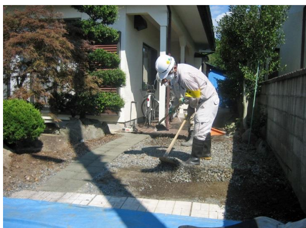
砂利・碎石の除去
