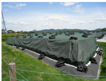
川前10区第2仮置場
