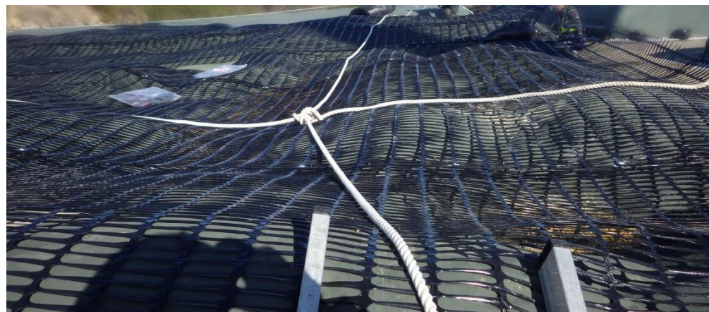
ジオグリッド（一軸延伸タイプ）を敷設した様子
