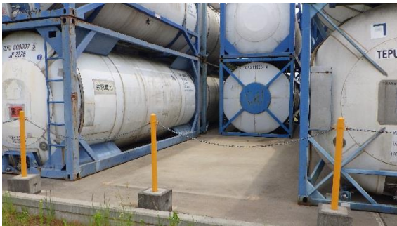
(写真 3-1) 空きスペースの状況
