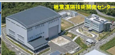
廃炉国際共同研究センター国際共同研究棟
