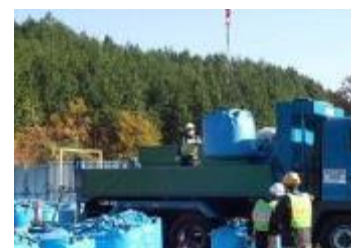
除去土壌等の車両積込状況
