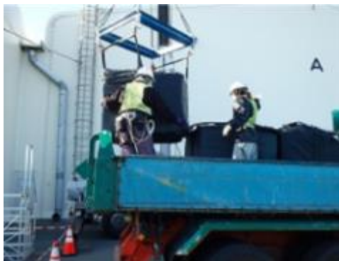
輸送車両への廃棄物積込状況
