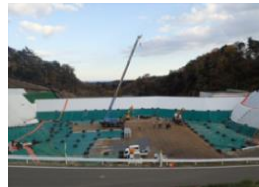
埋立処分施設の状況
