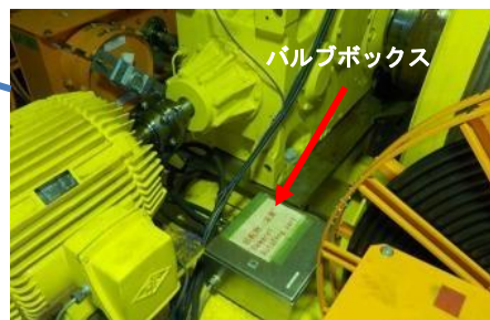
バルブボックス設置状況 クレーントロリ上部
