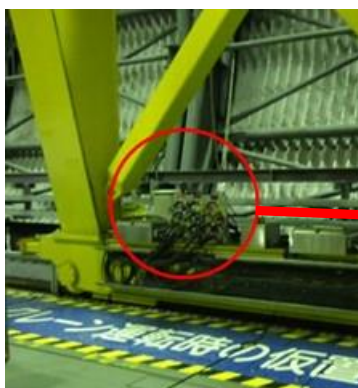
クレーン脚部
