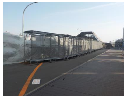
タービン建屋集中排気筒：東側
