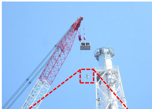
解体前調査の実施状況
