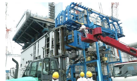
解体装置組立状況
