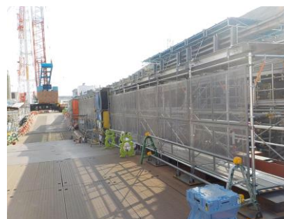
1・2号機排気筒：西側
