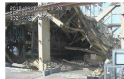
小がれき撤去状況 (4月12日)
