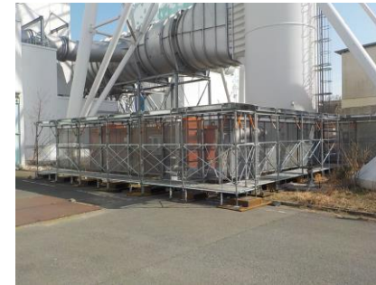
5・6号機排気筒：北側
