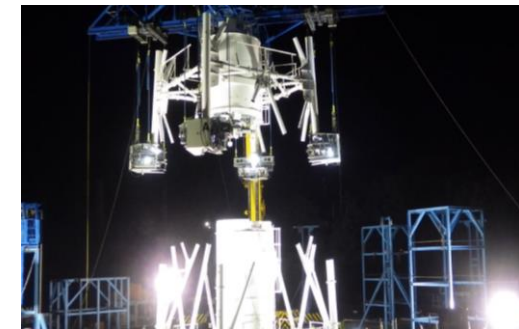
鉄塔・筒身一括除却吊上げ状況
