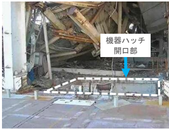
機器ハッチ養生作業前 (西作業床より)
