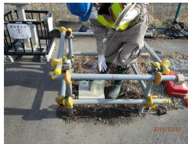
保管場における地下水の測定
