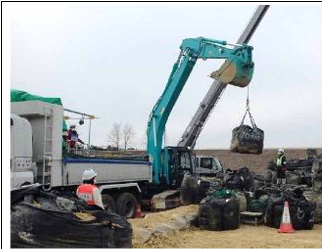
輸送物の積込作業確認
