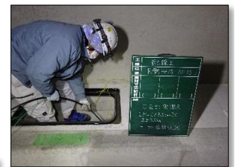
ケーブル設置作業
