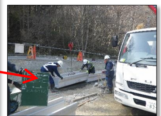
側溝の布設作業
