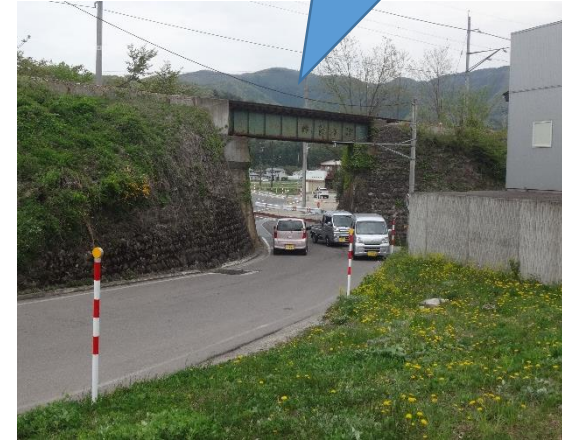
南会津町田島地内
