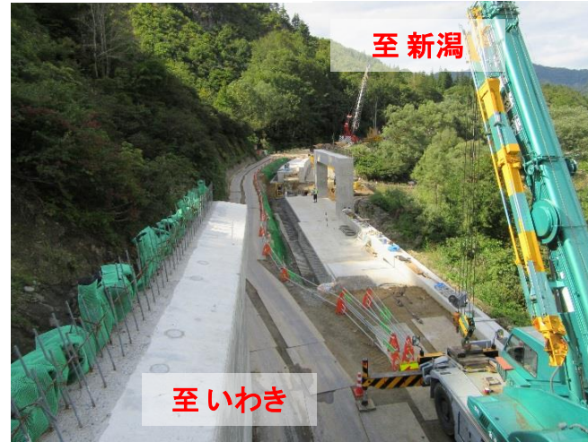
スノーシート工事状況
