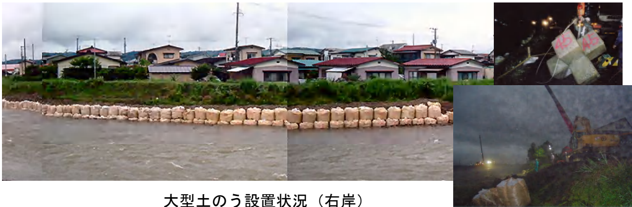
ブロック、大型土のう投入状況
