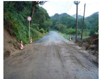
・崩落土砂撤去後
