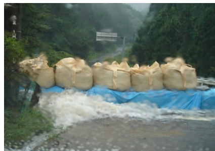
・大型土のう設置後
