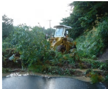
・崩落土砂撤去状況
