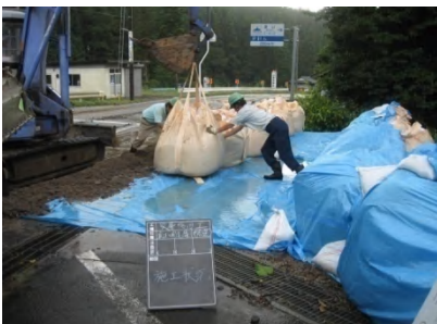
・大型土のう設置状況
