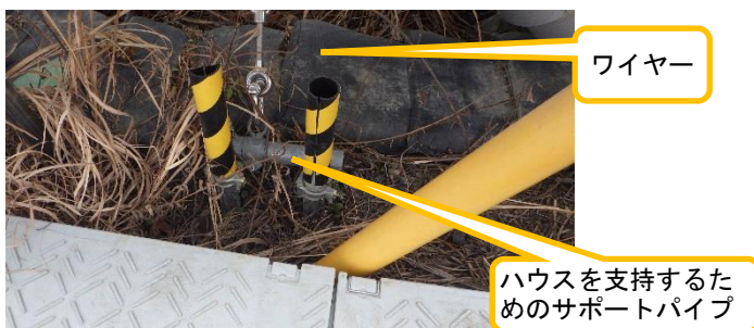
(写真1-3) (写真1-1)の青丸部分を拡大。ワイヤーはハウスを支持するためのサポートパイプに接続されている。
