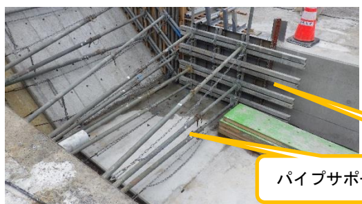
(写真5) 参考として同水路上流側でパイプサポートが機能している状況を撮影
