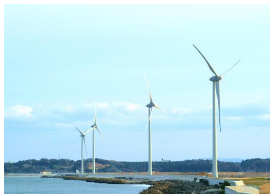
万葉の里風力発電所（南相馬市）
