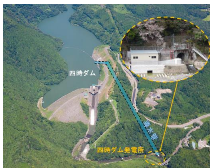
四時ダム ESCO 事業（いわき市）
