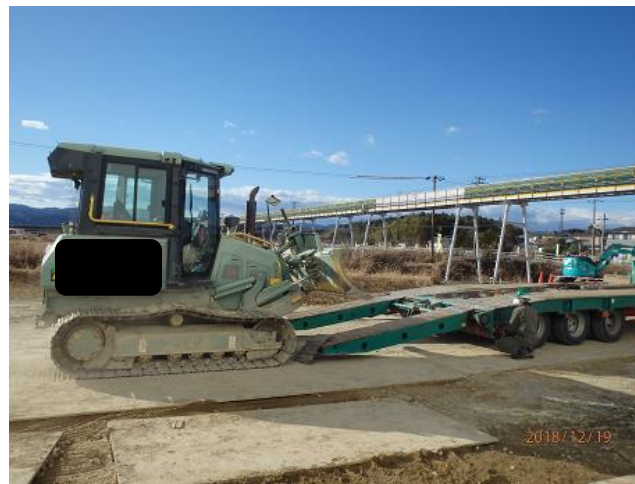
重機の積込状況の確認
