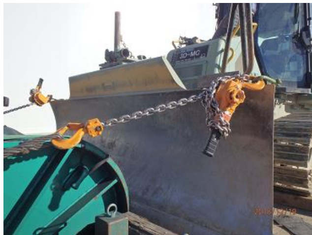
重機の固縛の状況確認
